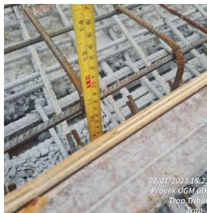
Gambar 3. Bekisting trap yang rendah
