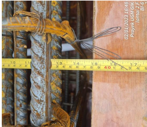
Gambar 4. Dimensi balok belum sesuai shop drawing
