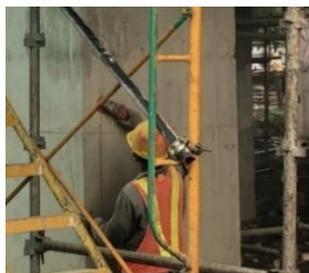
Gambar 3.3. Perataan permukaan kolom dengan gerinda
