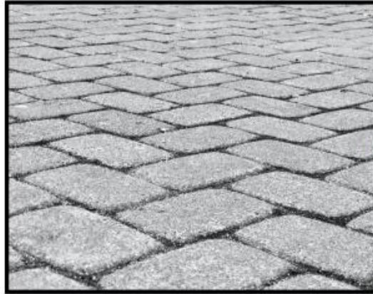
Gambar 9. Paving block yang dipasang
