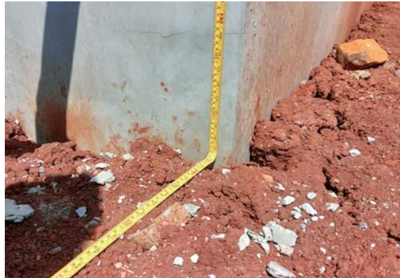
Gambar 4 Pengukuran timbunan tanah
